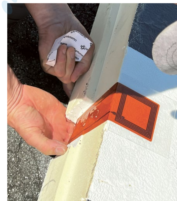
Die passiven R.O.S.I. Sensoren bestehen aus einer Antenneneinheit sowie Sensoren und werden im Dachschichtenpaket verbaut.
