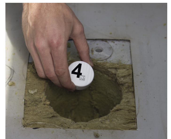
Beispiel einer nachträglichen Montage bei Faserdämmstoffen.
