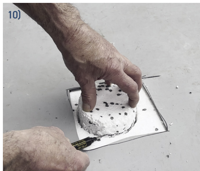
Gekürzten Bohrkern einsetzen.
