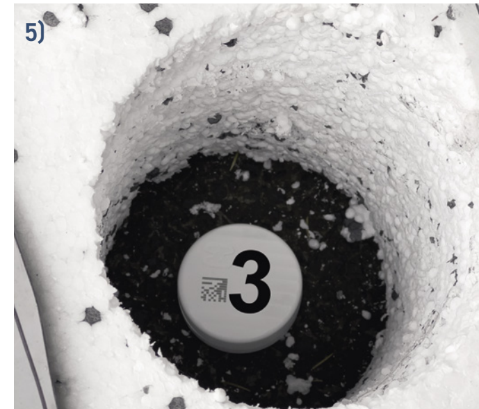
Einsetzen R.O.S.I. 2.0 Sensors auf der Dampfsperre.
