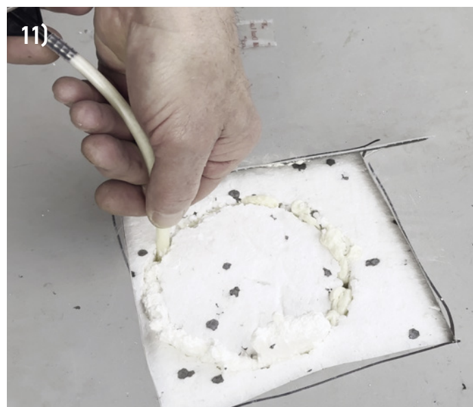
Befestigung der Wärmedämmung.
